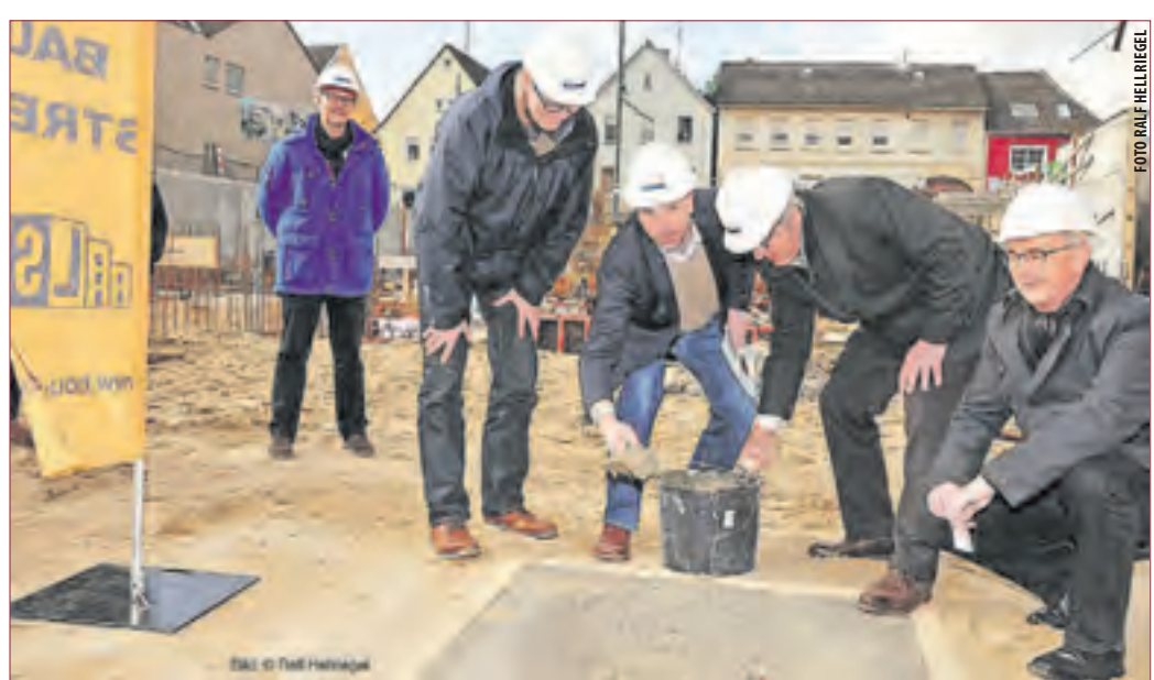
GRUNDSTEINLEGUNG: Grein, Wenzel, Staudt, Partsch, Dörfer. (v. l.)
