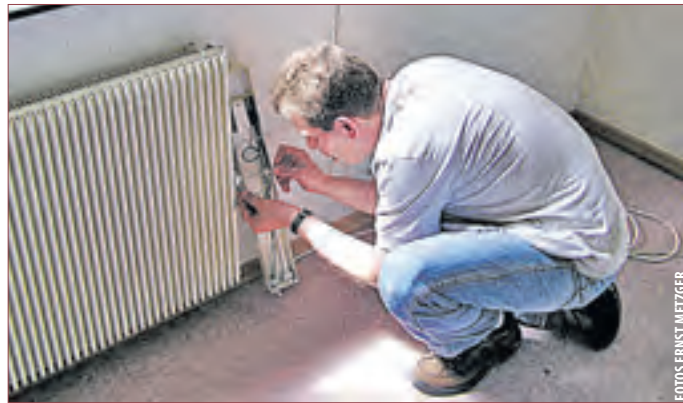
MONTAGE VOR ORT: Innerhalb eines Tages ohne Baustelle.
