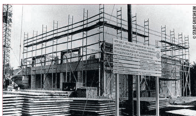
HAUS WALDECK in der Bauphase in den Jahren 1972-1973.
